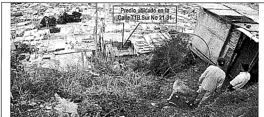
Foto 3. Vista desde la parte alta de la ladera evaluada, evidencia del fenómeno de remoción en masa descrito en el presente documento y la pérdida de suelo de confinamiento del relleno de cimentación sobre el cual se encuentra emplazada la vivienda ubicada al costado occidental del predio de la Calle 71B Sur No. 21-31.
