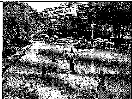
Foto 11. Evidencia del cerramiento y señalización con barreras físicas, del sector ubicado en la parte baja de la ladera (Fotografía tomada el 10-11-2010).
