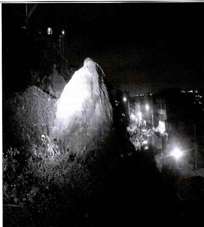
Fotografías 3 y 4. Se evidencia la posición y el tamaño de los bloques inestables que se localizaron hacia la parte media de la ladera y sobre los carriles que constituyen la Carrera 6 con Calle 190 lo cual ocasionó la obstaculización del tramo vial y una condición de riesgo por la posibilidad de caída de bloques adicionales por lo cual se solicitó la restricción de uso de dicho tramo. Noviembre 17 y 29 de 2010.
