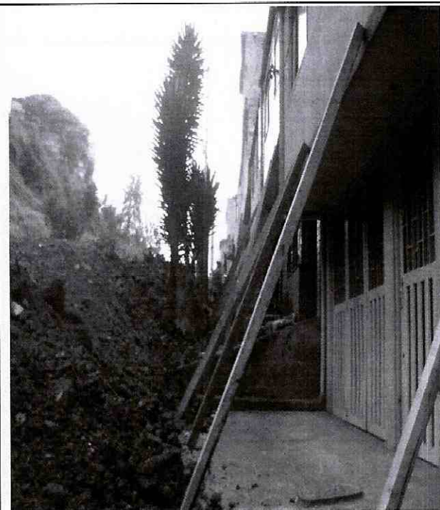
Fotografía 6. Se observan las medidas temporales implementadas (jarillón en fresado y tierra y cercos de madera) para la protección de las viviendas localizadas en la parte baja de la ladera para el proceso de retiro controlado de bloques de roca inestables. Noviembre 17 y 29 de 2010.
