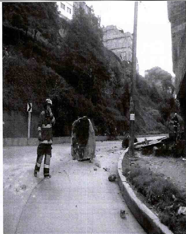
Fotografías 3 y 4. Se evidencia la posición y el tamaño de los bloques inestables que se localizaron hacia la parte media de la ladera y sobre los carriles que constituyen la Carrera 6 con Calle 190 lo cual ocasionó la obstaculización del tramo vial y una condición de riesgo por la posibilidad de caída de bloques adicionales por lo cual se solicitó la restricción de uso de dicho tramo. Noviembre 17 y 29 de 2010.
