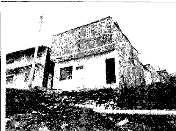
Foto 5. Se observan elementos expuestos de las redes de las diferentes empresas prestadoras de servicios públicos.
