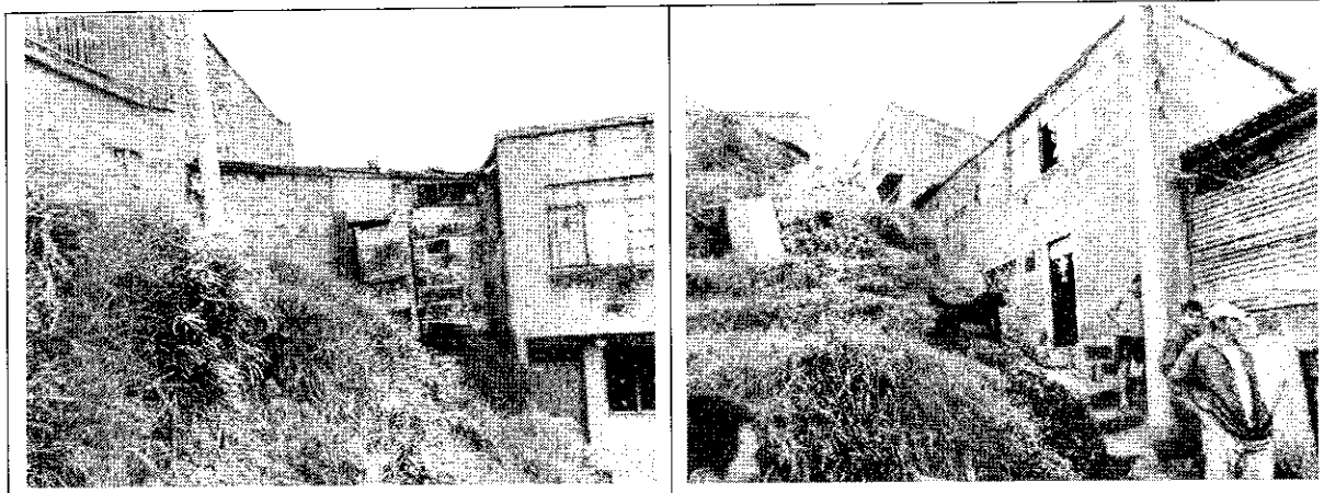
Fotos 9 y 10. Se evidencia como el material movilizado, se deposita sobre la Calle 76 A Sur, afectando la funcionalidad de las viviendas allí emplazadas.
