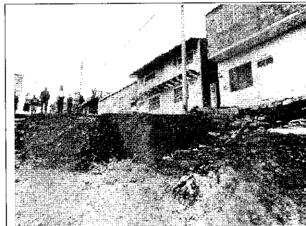
Fotos 3 y 4. Escarpe principal del proceso. Se evidencia la pérdida de funcionalidad de las viviendas localizadas en la corona del proceso, sobre la Carrera 18 H y sobre la Calle 76 A Sur.
