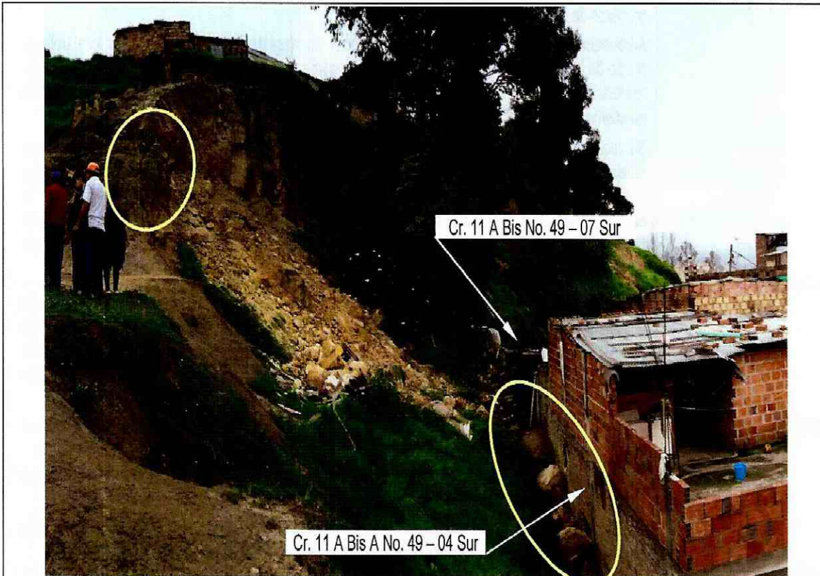
Fotografía 1. Vista general del sector evaluado. Se observan los materiales desprendidos del talud que impactaron los predios de la Cr. 11 A Bis A No. 49 - 04 Sur (al frente) y Cr. 11 A Bis No. 49 - 07 Sur (atrás). Nótese una primera cuña inestable del talud.
