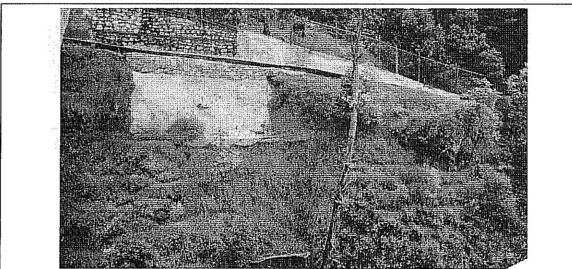
Fotografía 2. Vista general del costado oriental del talud localizado en la parte posterior del predio de la Cra. 4 No. 87 A – 60, el cual se encuentra estabilizado con obras tipo anclajes, drenaje y empradización, entre otras.
