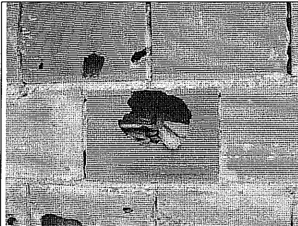
Foto 5. Ladrillos con huecos generados con la acción de una fuerza leve impuesta por los dedos.
