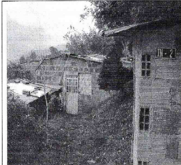
Foto 1. Vivienda del predio de la Carrera 4 Este No. 163A-64 Int. 2.
