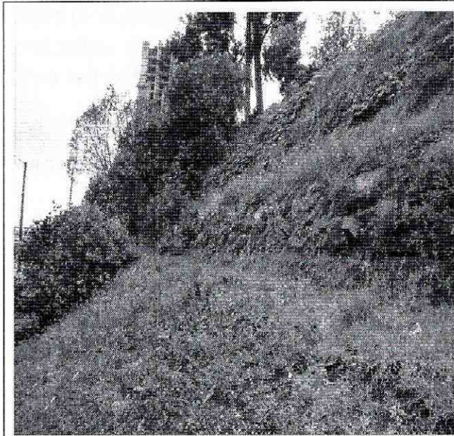
Foto 3. Obras de protección y/o estabilización del talud de corte localizadas hacia el oriente del proceso identificado.
