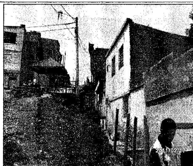
Foto 8. Tipología de las viviendas ubicadas en el sector evaluado, las cuales se encuentran construidas de forma escalonada por la topografía de la ladera donde se emplazan.
