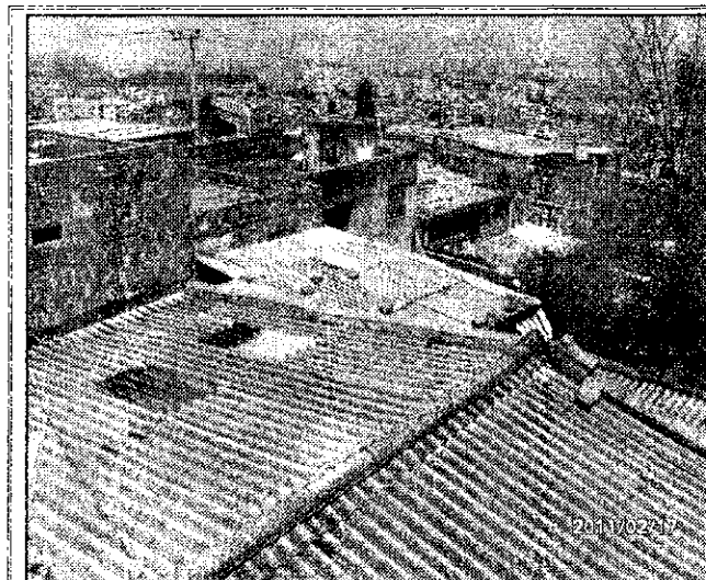
Foto 7. Cubiertas de algunas viviendas del sector evaluado que no presentaron afectación por acumulación de granizo, ni por los fuertes vientos presentados.
