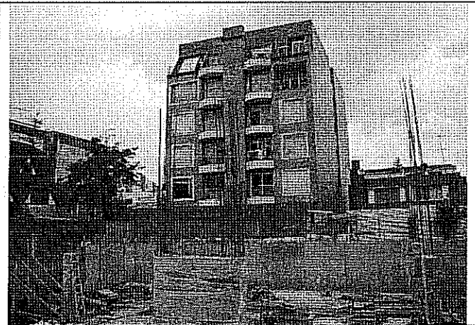
Foto 8. Edificio Oasis de Santa Bárbara visto desde el emplazamiento del proyecto urbanístico Marizagua 117. Nótese la presencia de muros de concreto como medida de estabilización del talud generado en dicho sector.
