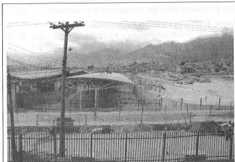
Foto 8. Vista parcial de las obras de construcción del portal de Transmilenio del 20 de Julio, las cuales se desarrollan hacia el costado nororiental y aproximadamente a 30 m del emplazamiento de las viviendas visitadas.
