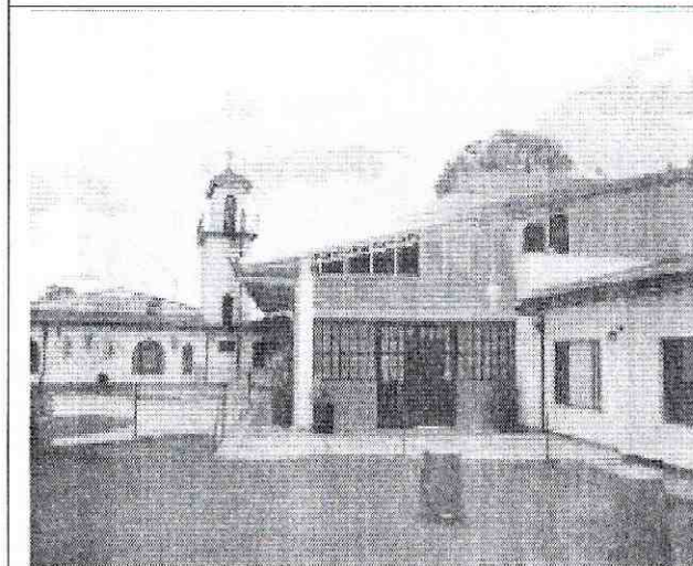
Fotografía 6. Vista Colegio San Ángelo donde se presentaron afectaciones en zonas de Gimnasio, Transición y Baños.
