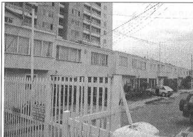
Foto 1. Viviendas de la hilera oriental del Conjunto Residencial El Pórtico, localizado en la Calle 142 No. 13-47.
