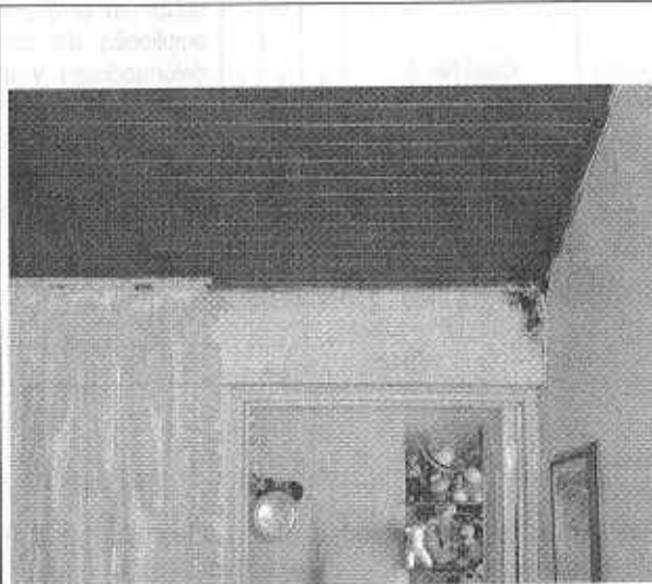
Foto 6. Grietas de tendencia vertical en el punto de contacto entre los muros de la ampliación (izquierda) y la construcción original (1er nivel).
