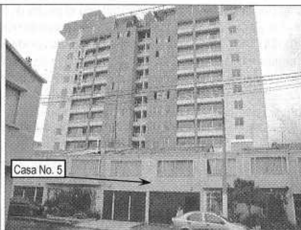
Foto 4. Localización de la Casa No. 5 del Conjunto Residencial El Pórtico con relación al edificio nuevo.
