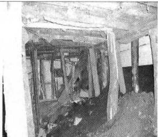
Fotografía 8. No se evidencian avances significativos respecto a lo evidenciado en el mes de abril de 2010 a nivel de la cimentación de la vivienda (obsérvese fotografía 6). Mayo 11 de 2010.
