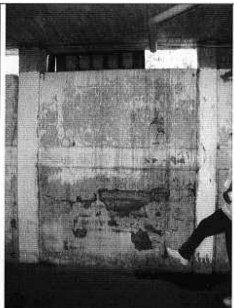
Foto 2. Configuración de los muros de estabilización de los taludes de corte, propicios para la ocurrencia del fenómeno de columna corta.
