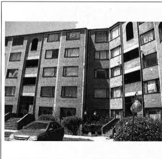
Foto 1. Tipología de los bloques de apartamentos que conforman la primera etapa del Conjunto Multifamiliar Canapro.
