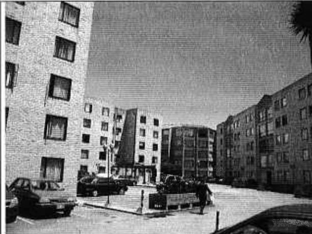
Foto 3. Plazoleta interior de la última etapa del conjunto multifamiliar Canapro. La zona común corresponde a una losa de concreto que corona el sótano de parqueaderos.
