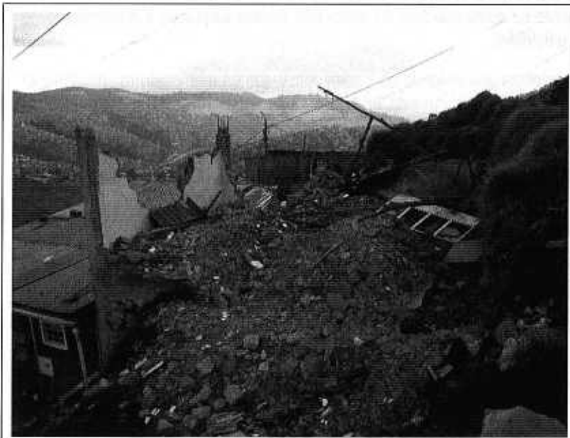
Foto 3. Vista del Lote 39 Manzana 19 (De acuerdo con CT-4862) ubicado hacia la parte alta del talud, evidencia de la acumulación de escombros sobre el mismo.
