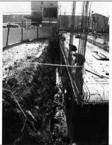
Foto 9. Estado de las obras en el sector donde se localizaba el muro de cerramiento entre ambos predios.
