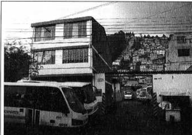
Foto 1. Vista frontal de la vivienda de la Carrera 8 No. 192-42 (izquierda), y del parqueadero de busetas del predio de la Carrera 8 No. 192-32.
