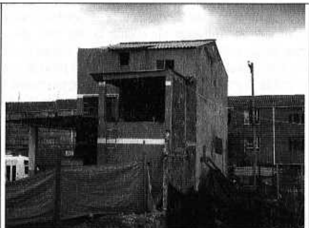
Foto 2. Vista posterior de la vivienda de la Carrera 8 No. 192-42, y de la estructura adosada en la que se localiza en tanque de almacenamiento de ACPM.
