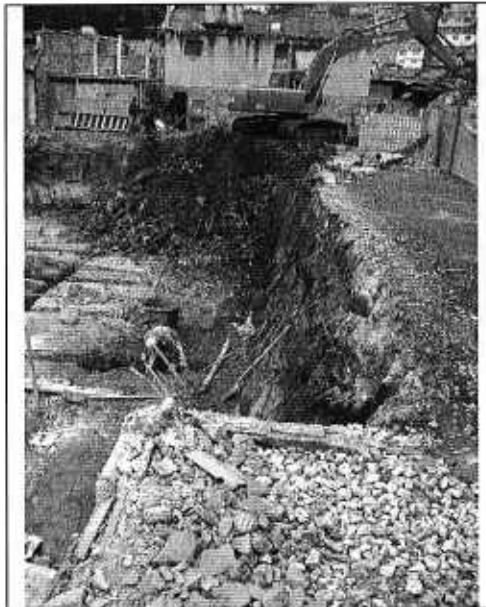
Foto 13. Sector en el que se localizaba el muro de lindero entre los dos predios.
