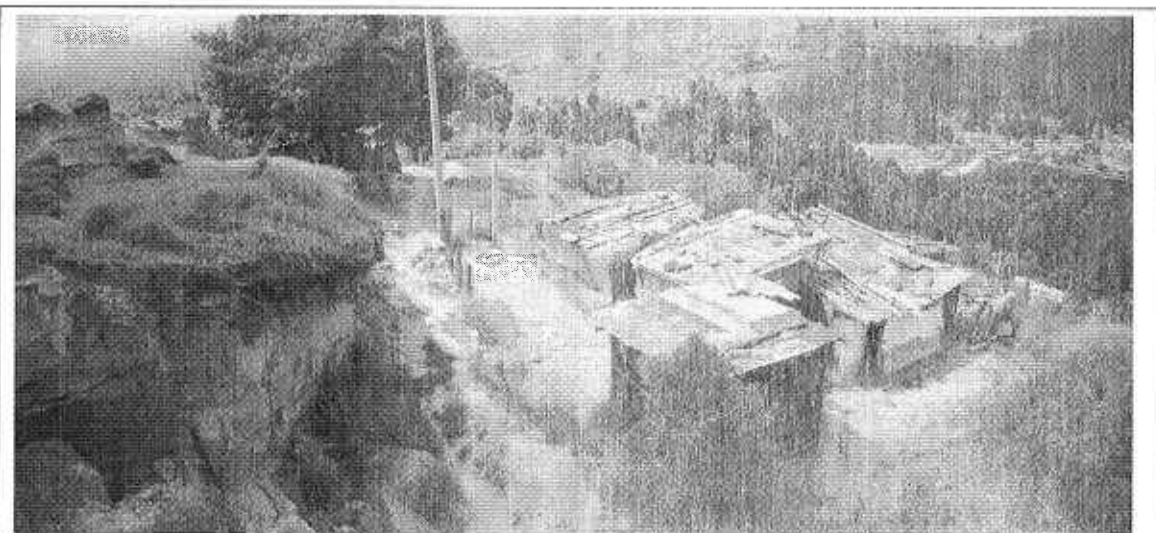
Fotografía 8. Vista general de los Predios E, F y G de la Manzana 36, los cuales fueron evacuados por compromiso en su estabilidad y habitabilidad. Este sector corresponde al extremo sur-occidental del Desarrollo Manantial, que a su vez es el más alto topográficamente.
