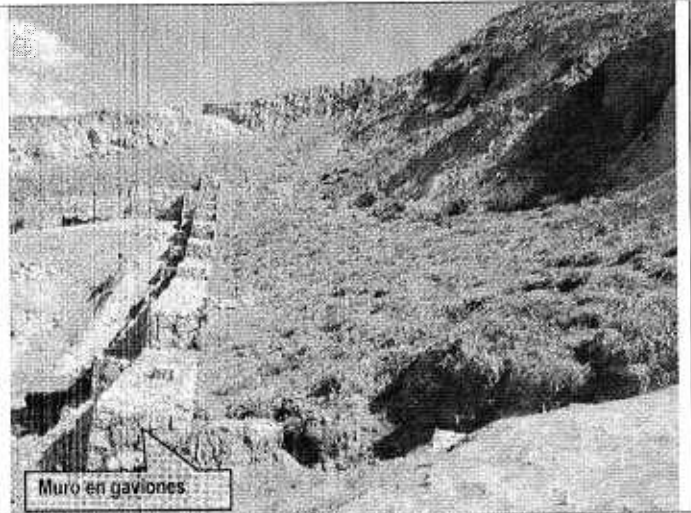
Foto 2. Estado final de las obras Sitio 3, conformación del terreno, construcción de muro en gaviones y cuneta en piedra pegada. Tomado de Informe final de Interventoría 285 de 2006.
