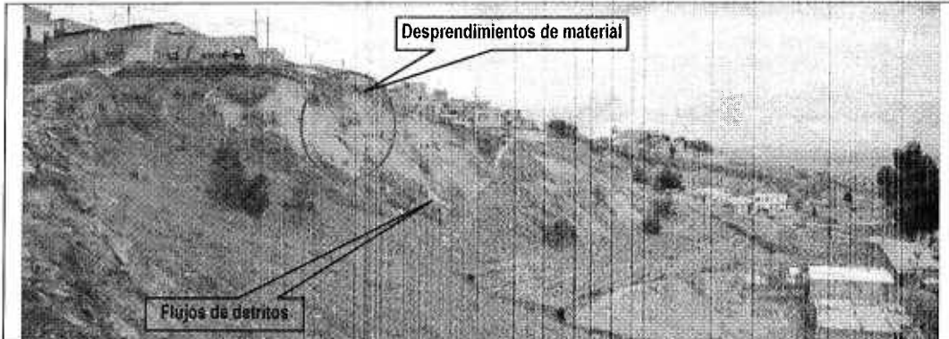
Foto 2. Vista desde la parte baja, costado norte del talud evaluado en el sector de la Carrera 76C entre la Calle 62H Sur y la Calle 62I Sur del Barrio Tres Reyes Primer Sector de la Localidad de Ciudad Bolívar, evidencia de desprendimientos de material hacia la parte media del mismo y flujos de detritos en la parte media - baja del mismo (fotografía tomada del DI-4481 el 14-04-10).
