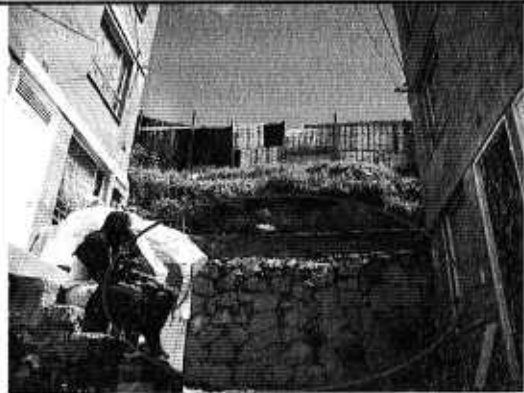
Foto 4. Evidencia de la existencia de un muro en piedra pegada, como medida de contención y/o protección en el talud de corte ubicado al costado occidental del predio evaluado donde se encuentra la urbanización "Altos de Galicia".
