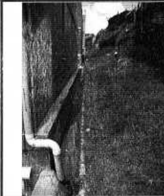
Foto 5. Evidencia de la existencia de una cuneta para el manejo de escorrentía superficial hacia la parte alta del talud de corte ubicado al costado occidental del predio evaluado donde se encuentra la urbanización "Altos de Galicia".
