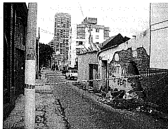
Fotografía 3 Vista general de la Calle 66 entre carreras 4A y 5, evidencia de la reducción de carril a la altura de la vivienda afectada.
