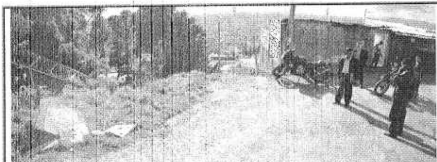
Foto 4. Vista desde la parte alta de la ladera evaluada, sector vial de la Carrera 5 Este a la altura de la Calle 45B; se evidencia la carencia de sistemas para la captación y manejo de los flujos de escorrentía superficial (aguas lluvias) (Caso 1).
