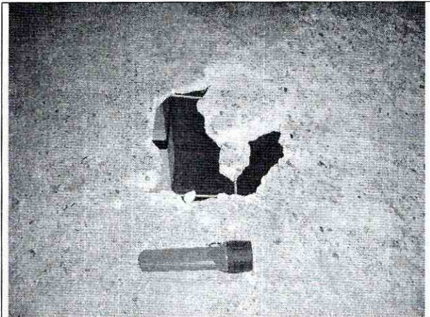
Foto 4. Vista de detalle del hueco en la losa de entripiso que conforma el primer nivel del edificio, zona de parqueaderos.
