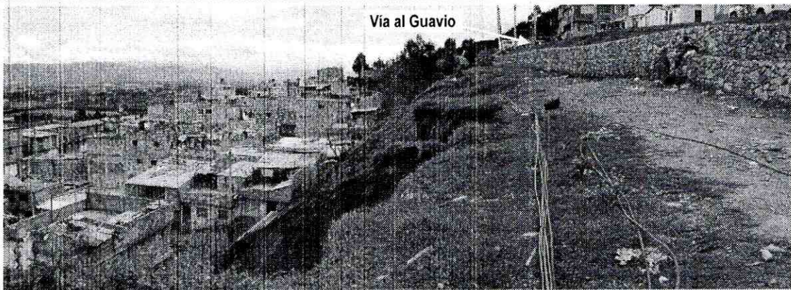
Fotografía 4. Muro de gaviones localizados en la parte alta del sector inestable, construido por la UAERMV como medida de estabilización de la vía al Guavio. Se observa la corona del deslizamiento.
