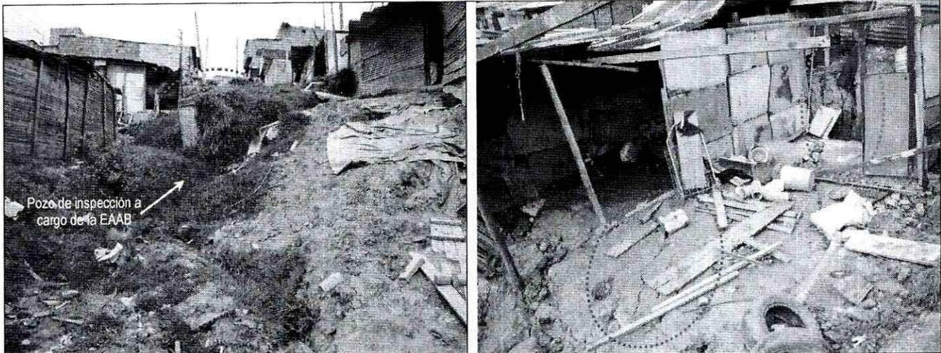
**Foto 4 y 5.** Se observa el pozo de alcantarillado a cargo de la EAAB; pozo que según lo observado presenta fugas, colmatación y falta de mantenimiento preventivo. Adicionalmente se observa el deterioro y falta de mantenimiento de las viviendas evaluadas, así como algunas de las grietas identificadas en el terreno.
