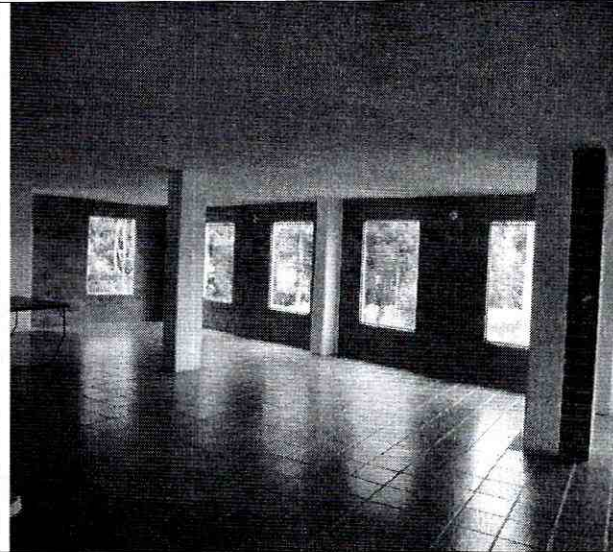
Fotografía 2. Características estructurales de la edificación en el segundo nivel, no se evidenciaron afectaciones que comprometan la estabilidad y funcionalidad de la misma. Junio 29 de 2010.
