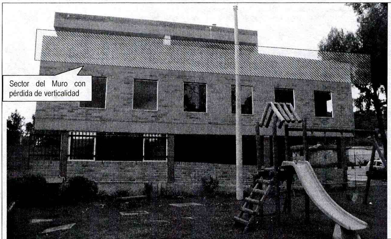
Fotografía 1. Característica generales de la fachada norte del edificio de administración de la Agrupación de Vivienda Bacatá Reservado, el cual corresponde a un edificación de tres nivel tipo pórtico con muros de fachada y antepecho en ladrillo a la vista. Se identifica el muro que presenta pérdida de verticalidad. Junio 29 de 2010.
