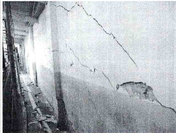
Fotos 8 y 9. Agrietamiento severo e inclinación en losa de contrapiso y agrietamiento en muro del costado suroccidental de la bodega de la Carrera 103A No. 22F-61.
