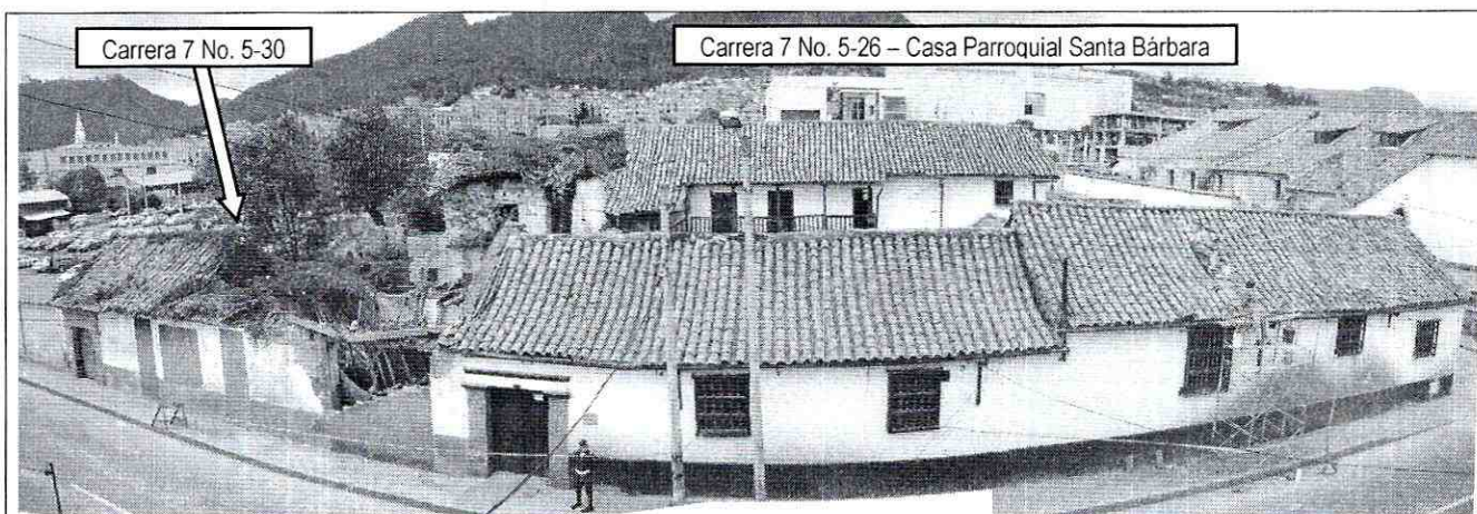
Foto 1. Panorámica de los predios de la Carrera 7 No. 5-30 (izquierda) y de la Carrera 7 No. 5-26, Casa Parroquial de Santa Bárbara.
