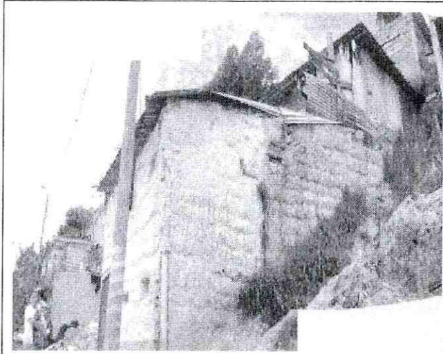
Fotografía 1. Vista del costado norte de la vivienda emplazada en la Manzana 8 Lote 8 en el Barrio Malvinas.
