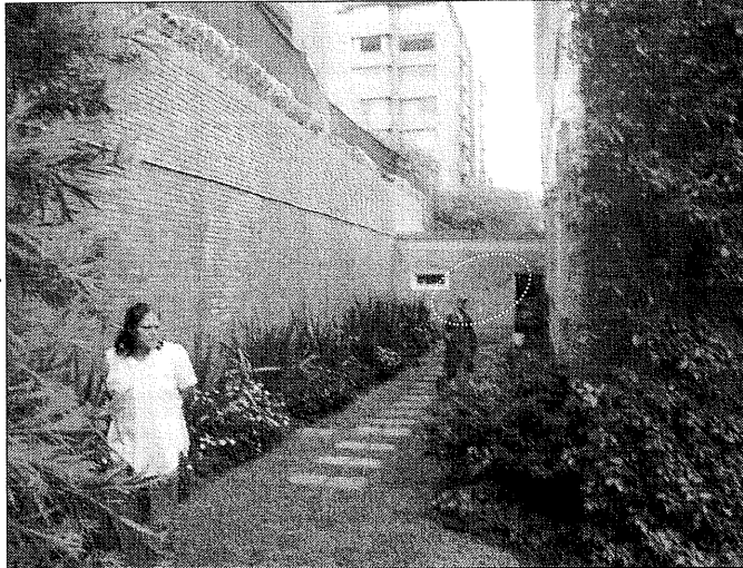
Foto 2 y 3. Se observan las grietas identificadas en una de las tres edificaciones evaluadas en el predio de la Calle 87 # 12 – 55 (edificación 1, ver figura 1), donde actualmente funciona la Embajada de Austria; edificación de un nivel ubicada en el costado noroccidental del predio y que según lo observado presenta daños estructurales que comprometen su estabilidad estructural y su habitabilidad en el corto plazo bajo cargas normales de servicio. (Zona de Parqueadero).
