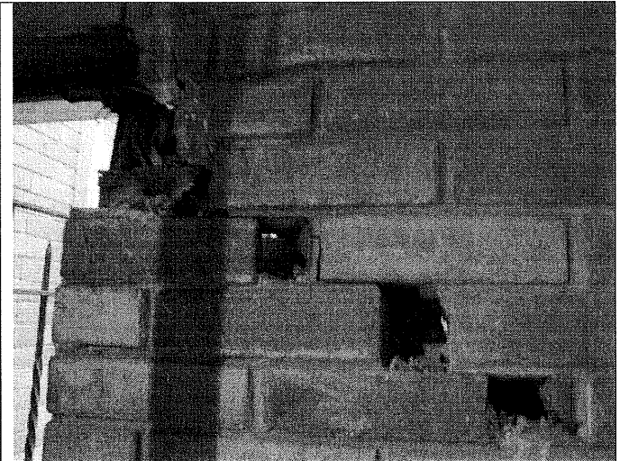
Foto 4 y 5. Se observan las grietas identificadas en una de las tres edificaciones evaluadas en el predio de la Calle 87 # 12 – 55 (edificación 1, ver figura 1), donde actualmente funciona la Embajada de Austria; edificación de un nivel ubicada en el costado noroccidental del predio y que según lo observado presenta daños estructurales que comprometen su estabilidad estructural y su habitabilidad en el corto plazo bajo cargas normales de servicio. (Zona de Parqueadero).
