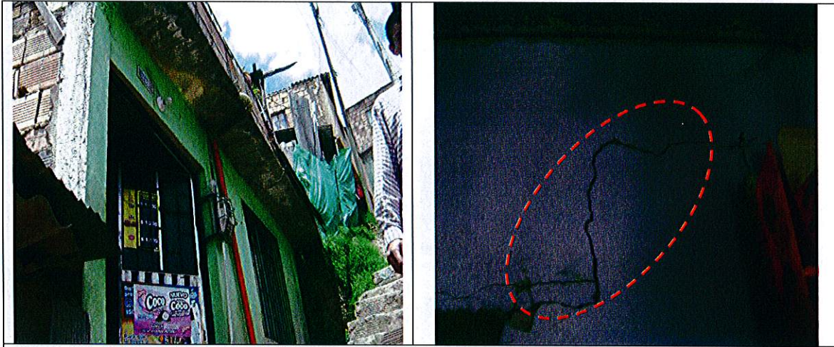
Fotografías No.21-22.- Vivienda emplazada en la Manzana 5 Lote 13 Diagonal 71C Sur No.1C - 09 Este donde habita la señora Hermilda Suns Quintero y su familia. La vivienda consta de dos niveles en mampostería semiconfinada por vigas y columnas, se observan fisuras de tendencia horizontal y diagonal en los muros divisorios y de cerramiento, así como fisuras a nivel de piso. Los daños evidenciados comprometen la habitabilidad y estabilidad de la vivienda en el corto plazo, se recomienda su evacuación.
