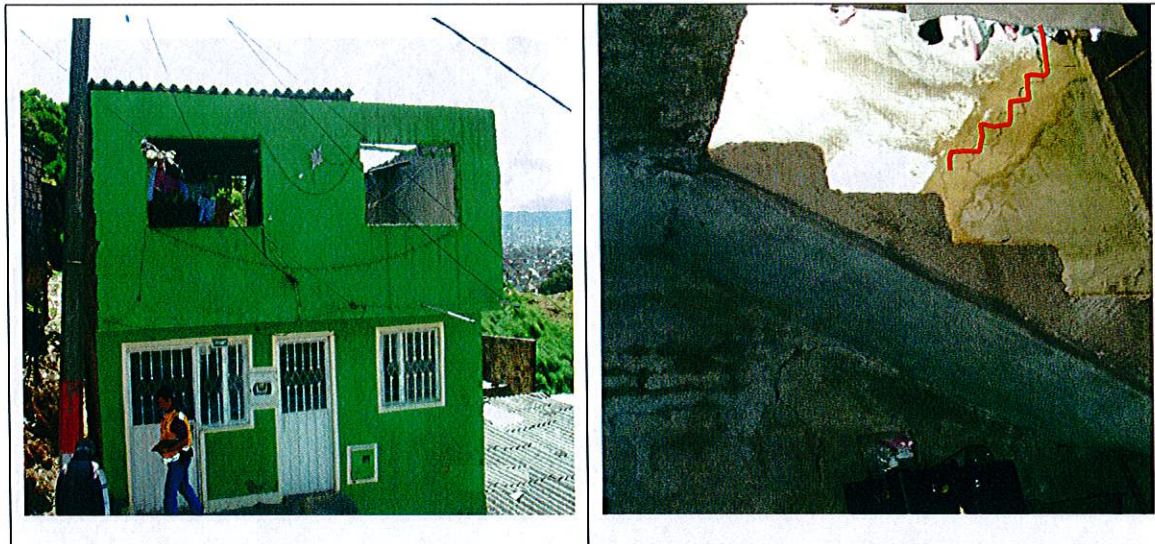
Fotografías No. 17-18.- Vivienda emplazada en la Manzana 18 Lote 3 Diagonal 71C Sur No.1D - 56 Este donde habita la señora Yolanda Castellanos y su familia. La edificación consta de dos niveles construida en mampostería parcialmente confinada por vigas y columnas, se evidencian grietas escalonadas en muros de cerramiento y fisuras a nivel de piso. Los daños evidenciados comprometen la habitabilidad y estabilidad de la vivienda en el corto plazo, se recomienda su evacuación.
