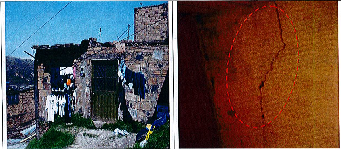
Fotografías No. 33 – 34.- Vivienda emplazada en la Manzana 10 Lote 9 Diagonal 70B Sur No.1D - 35 Este donde habitan Graciela Ruiz Segura y Leonel Rodríguez y su familia. La vivienda consta de un nivel construido en mampostería parcialmente confinada por columnas, se observan grietas de tendencia diagonal en los muros divisorios y de cerramiento, así como grietas a nivel de piso con aperturas superiores a los 3mm. Los daños evidenciados comprometen la habitabilidad y estabilidad de la vivienda en el corto plazo, se recomienda su evacuación.
