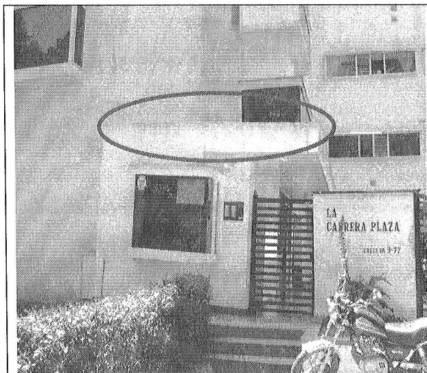
Fotografía 1. Vista costado Norte entrada conjunto residencial La Cabrera Plaza (Evidencia de asentamientos en portería).
