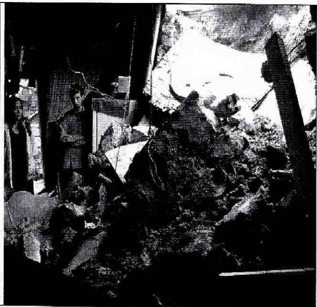
Foto 2. Costado Sur del Lote 10 de la Manzana 53. Se observa el material generado tras el colapso del muro en piedra pegada que confina un relleno antrópico existente en el Lote 8 de la Manzana 53; material que se depositó en la parte baja del relleno, donde se localiza el Lote 10 de la Manzana 53.
