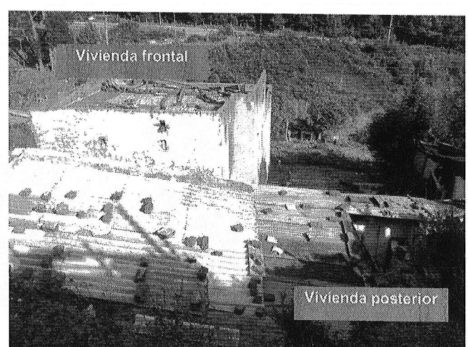
Fotografía 8. Vista posterior del predio de la Transversal 8 Este No. 5 - 95 Sur. Hacia el fondo se observa la construcción de dos pisos y en primer plano la vivienda de un piso, afectada por el deslizamiento.
