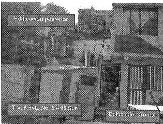
Fotografía 7 Predio ubicado en la Transversal 8 Este No. 5 - 95 Sur, afectada por el deslizamiento de una porción de suelo de aproximadamente 3 m 3 . En el predio existen dos viviendas independientes; la del fondo es la afectada por el proceso.
