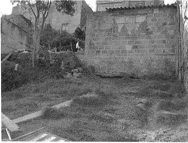
Fotografía 13. Características del terreno en que se emplaza la vivienda de la Transversal 8 Este No. 5 – 75 Sur.
