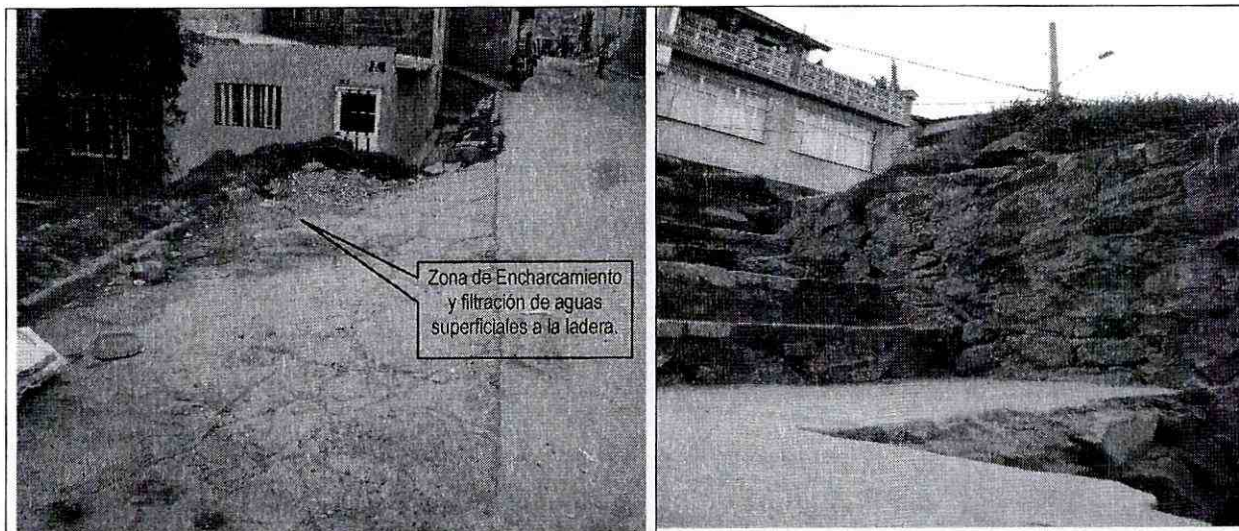
Foto 1. Zona de parqueo localizada sobre la carrera 18M con calle 61B sur del Barrio La Escala 1er Sector , nótese el avanzado estado de deterioro del pavimento (Fotografía tomada el 19 de Febrero de 2009)
