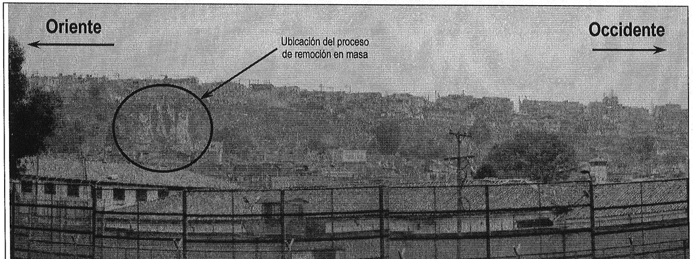
Foto 15. Vista general del antiguo frente de explotación de materiales. Se observa el proceso de remoción en masa que afecto sus taludes, ubicados al costado Norte de la Diagonal 51 Sur entre la Carrera 5A y la Carrera 5 Bis A.
