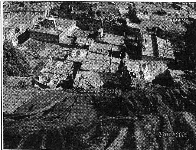
Foto 33 y 34. Se observa el talud afectado por el proceso de remoción en masa y la cobertura en plástico dispuesta en el mismo como medida de mitigación ante un posible avance en el proceso de remoción en masa.
