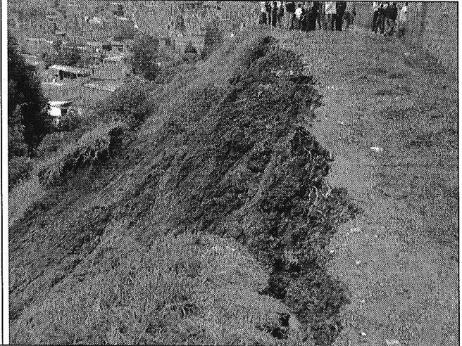
Foto 19 y 20. Vista del proceso de remoción en masa. Se observa la corona y el material depositado en la parte media y baja del talud.
