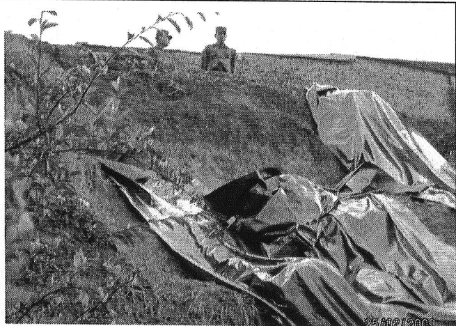
Foto 18. Parte alta del talud. Se observa un estrato de limo en la corona del talud.
