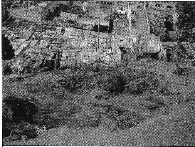
Foto 19 y 20. Vista del proceso de remoción en masa. Se observa la corona y el material depositado en la parte media y baja del talud.
