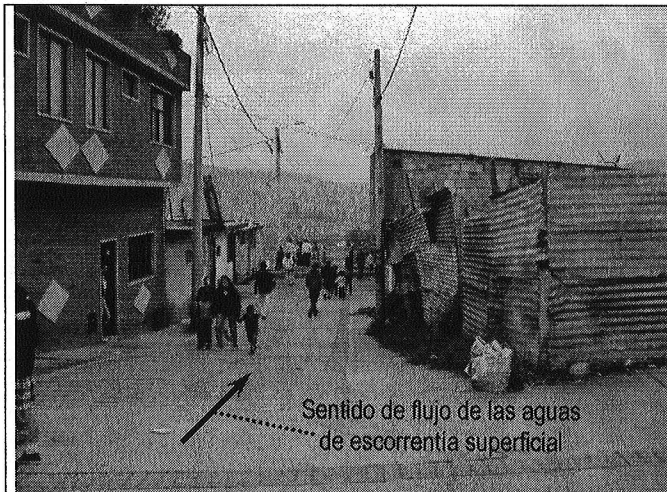
Foto 1. Vista general de la Carrera 5A entre la Diagonal 52 Sur y la Diagonal 51 Sur. En el sector la escorrentía superficial fluye de Sur a Norte.
