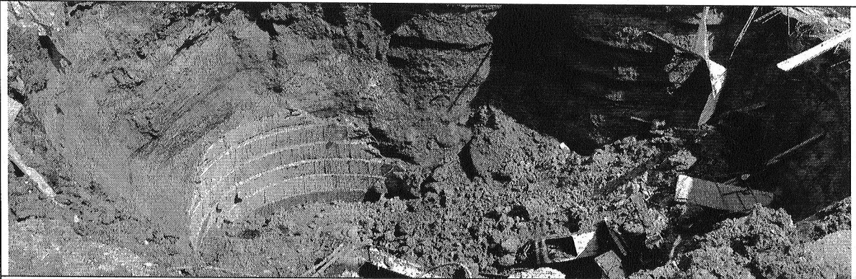
Foto 2. Vista desde la parte superior, costado sur-occidental de los pozos de cimentación (caissons) afectados, evidencia de la maquinaria que se encuentra al interior de los mismos.
