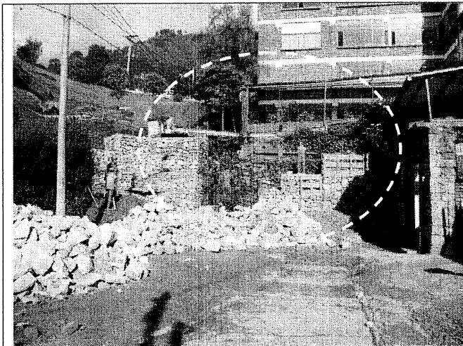
Fotografía No. 2 y 3. Vista desde el Costado Nor-occidental del predio de la Calle 46 No. 3-05 – donde funciona la Universidad – Unilatina en el barrio Pardo Rubio de la Localidad de Chapinero – se observan las obras sobre la ladera al igual que la construcción de un nuevo muro de contención en gaviones en la parte baja del sector donde se presentó la afectación (Tomada el 20 de Abril de 2010).
