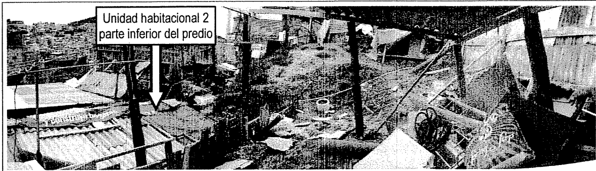
Fotografía 1. Vista general del predio de la Cll. 32 C Sur No. 3 – 05 Este. La foto está tomada desde la parte alta, y se observan los vestigios de la unidad habitacional que se encontraba en parte superior del predio, y la cubierta de la unidad habitacional de la parte inferior del mismo.
