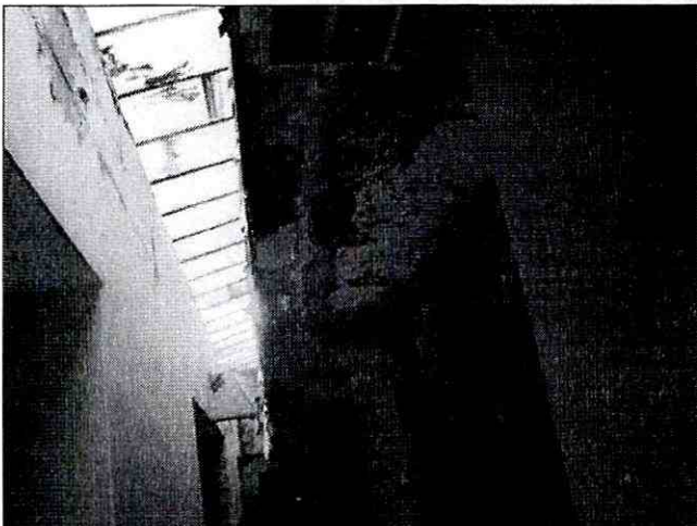
Foto 14 y 15. Se observa el alto contenido de humedad identificado en muros divisorios y de cerramiento. Se resalta que la humedad observada podría alcanzar el acero de refuerzo de los elementos estructural y generar su degradación acelerada, con el consecuente compromiso en la estabilidad estructural parcial y/o total de la edificación.
