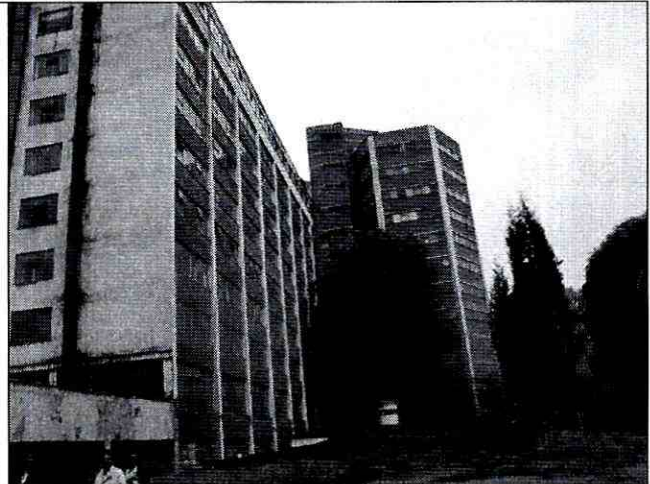
Foto 10 y 11. Vista general de la edificación de nueve (9) niveles construida en lo que según la inspección son pórticos y entrepisos en concreto reforzado, con muros divisorios y de cerramiento no estructurales en mampostería.
