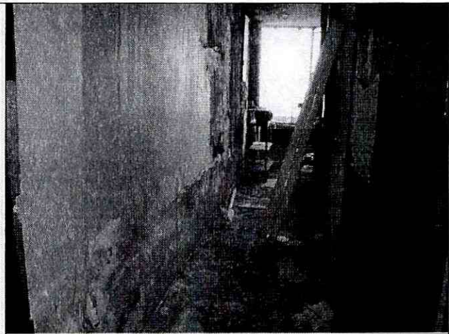
Foto 14 y 15. Se observa el alto contenido de humedad identificado en muros divisorios y de cerramiento. Se resalta que la humedad observada podría alcanzar el acero de refuerzo de los elementos estructural y generar su degradación acelerada, con el consecuente compromiso en la estabilidad estructural parcial y/o total de la edificación.
