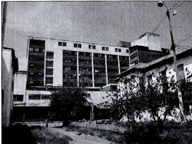
Foto 10 y 11. Vista general de la edificación de nueve (9) niveles construida en lo que según la inspección son pórticos y entrepisos en concreto reforzado, con muros divisorios y de cerramiento no estructurales en mampostería.
