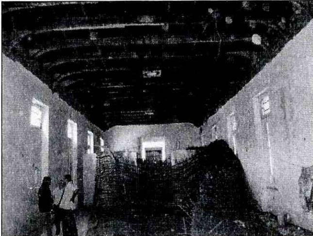
Foto 4. Se observa el entramado en madera que conforma el sistema de cubierta de una de las edificaciones en mampostería simple evaluadas. Adicionalmente se observan los escombros generados tras el colapso del cielorraso en esterilla de guadúa y barro.
