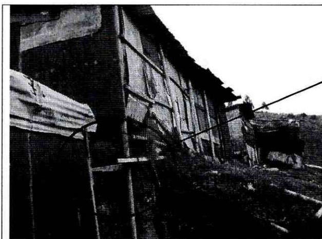
Foto 1. Costado occidental de la vivienda emplazada en el predio evaluado. Se observa la afectación existen en el costado noroccidental de la misma.
