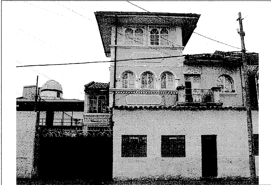
Fotografía 1. Edificación emplazada en el predio de la Calle 33 A # 17 - 35, Barrio Teusaquillo de la Localidad de Teusaquillo
