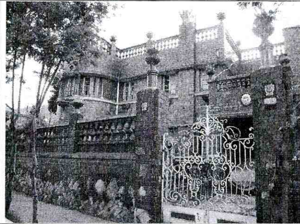
Foto 1. Vista exterior de la vivienda de la Avenida Calle 11 Sur No. 5A-65.
