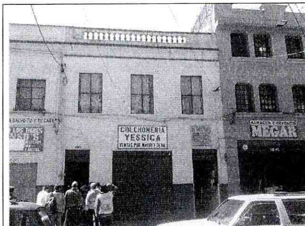
Foto 1. Vista de la fachada frontal (sobre la Calle 10) de la edificación emplazada en el predio de la Calle 10 No. 15-35.
