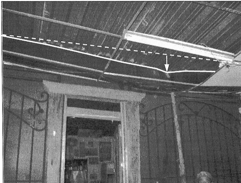
Fotografía 4 y 5. Deflexión excesiva de las vigas cajón que lo sostienen el entpiso del segundo nivel, en un área aproximada de 50 m 2 , tercio oriental del pasaje donde actualmente se adelantan obras, posiblemente para la ampliacion en altura del pasaje. Carrera 4 # 19 – 56.
