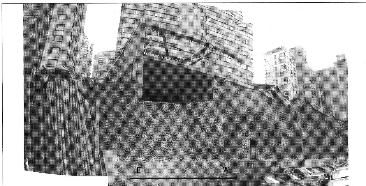
Fotografía 1. Pasaje Internacional Gourmet Olga Carrera 4 # 19 - 56, Barrio Las Nieves de la Localidad de Santa Fe, tercio oriental del pasaje donde actualmente se adelantan obras, posiblemente para una ampliación en altura.
