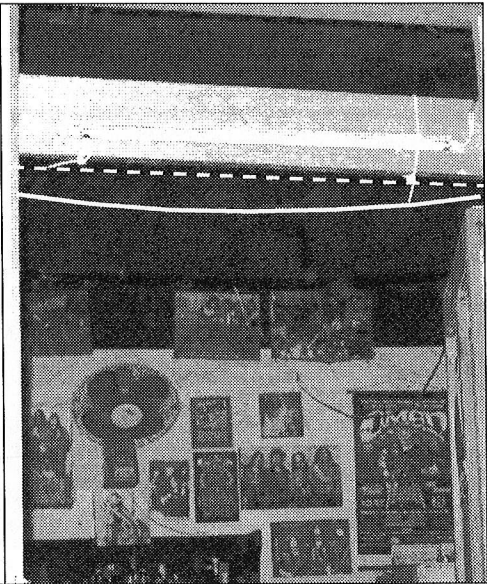
Fotografía 4 y 5. Deflexión excesiva de las vigas cajón que lo sostienen el entpiso del segundo nivel, en un área aproximada de 50 m 2 , tercio oriental del pasaje donde actualmente se adelantan obras, posiblemente para la ampliacion en altura del pasaje. Carrera 4 # 19 – 56.
