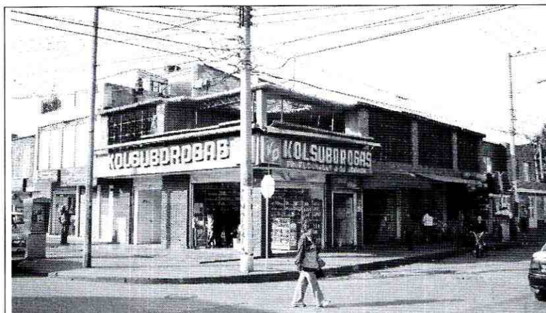
Foto 1. Vista general de la construcción emplazada en el predio de la Carrera 90 No. 70A-05.
