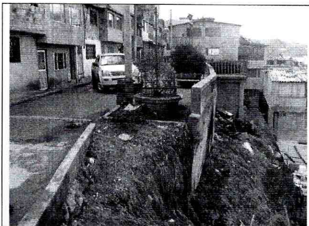
Foto 1. Vista general del muro de estabilización del relleno ubicado en la intersección de la Carrera 5B con Calle 192A (tomada del DI-4113).
