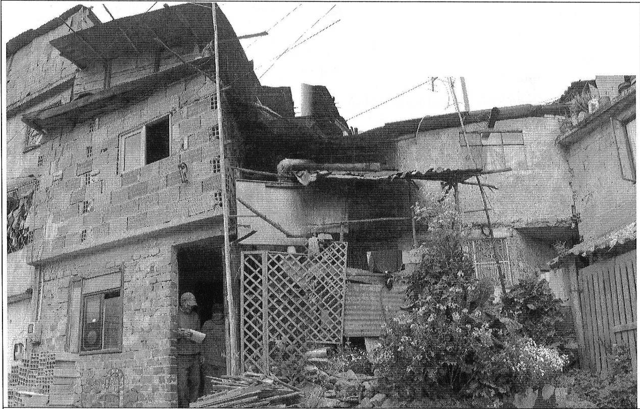
Fotografía 1. Edificación de la Diagonal 101 # 3 -51 Este, Interior 3, Barrio San Luis Altos del Cabo de la Localidad de Chapinero.
